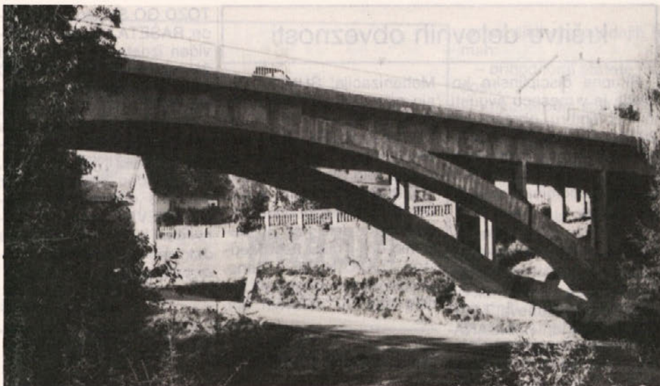
Zaradi dotrajanosti nosilne konstrukcije smo opravili sanacijo mostu čez reko Dobljičico v Črnomlju. Delo smo dokončali v pogodbenem roku. Izvajalec: GO Ljubljana, Foto: Vili Šuster
