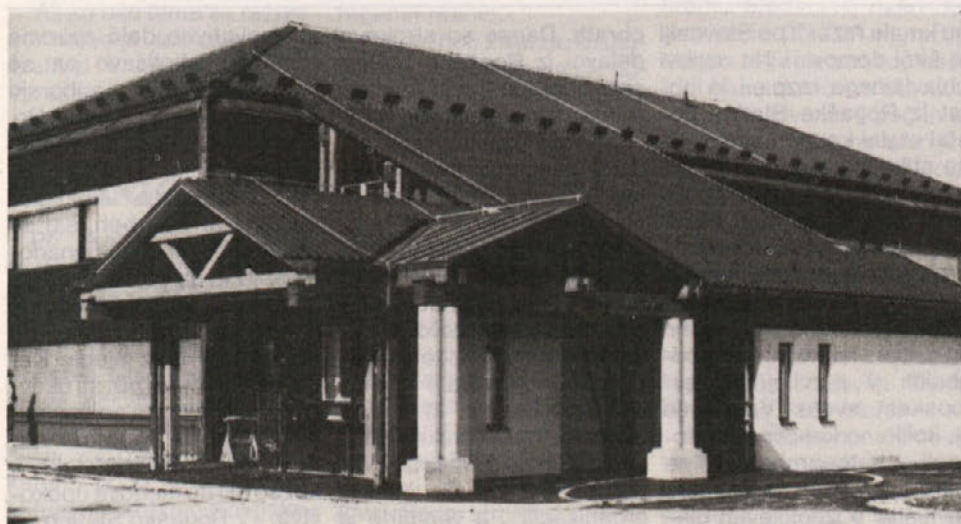
Nekaj dni pred njihovim praznikom – dnevom kolektiva Zarje, smo dokončali dozidavo: prestatitev vratarnice z vhodom v industrijsko prodajalno v Petrovčah. Izvajalec: GO Žalec, Foto: Vili Šuster
