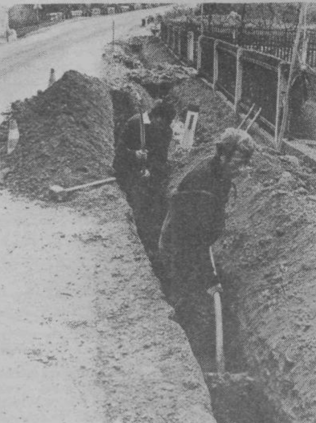
ŠMARJE-SAP — Šmarčani dobivajo nove telefonske priključke. Pri tem so si pomagali sami, na pomoč pa so jim s prostovoljnim delom pred časom priskočili tudi delavci PTT Ljubljana. Seveda pa vsega niso zmogli, zato te dni polagajo cevi za PTT vode. Delavci, ki so zaposleni v PAP Ljubljana, kopljejo za poštarje jarke in polagajo cevi na kilometer dolgi trasi v Šmarje Sapu. — Foto: Marjan Ciglič
