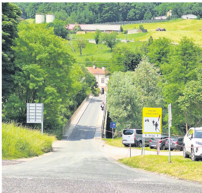
Most čez Savinjo v Rimskih Toplicah bodo porušili in v bližini zgradili novega, načrtovano je tudi novo krožišče. Hkrati bodo izvedeni protipoplavni ukrepi. (Foto: BA)
