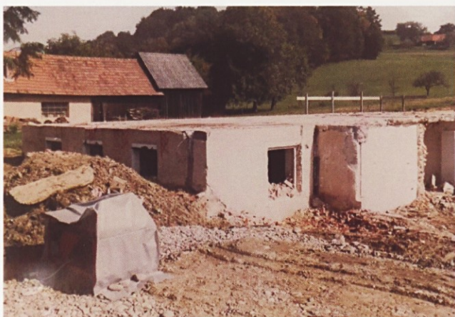
Rušenje stare stavbe, foto: arhiv šole
