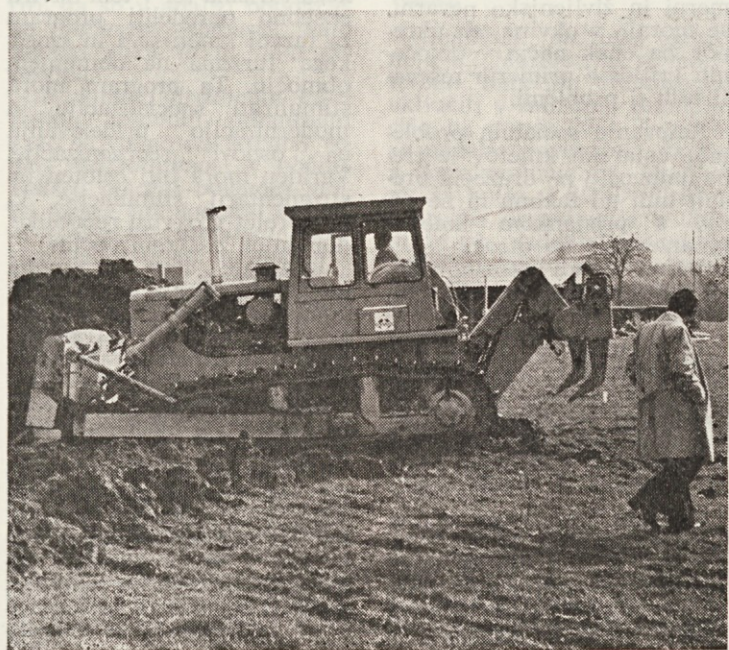
Pričetek del na izgradnji Rekreativno turističnega centra v Ptujju
