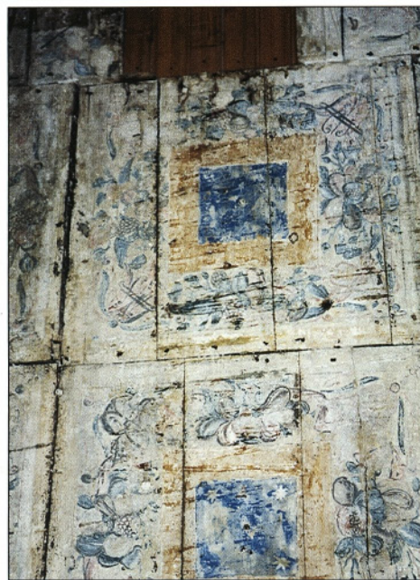
Del lesenega kasetiranega stropa pred restavriranjem (foto: D. Pečnik)
