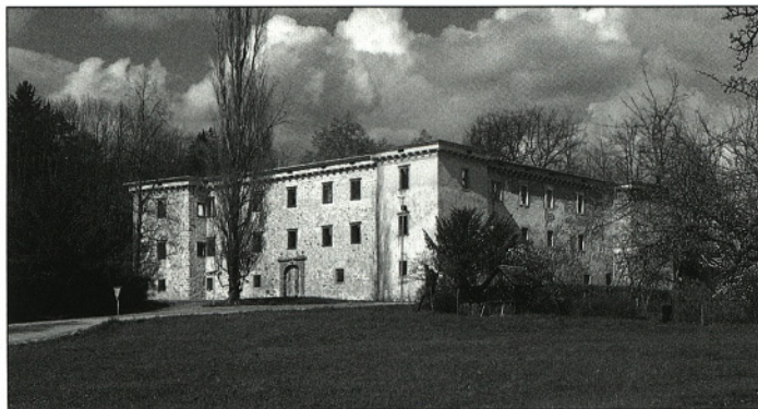
Zunanjščina delno obnovljenega dvorca
