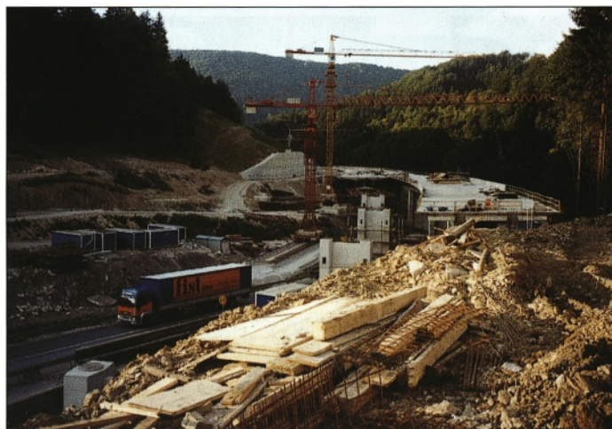
Gradnja viadukta (foto: T. Cerar)
