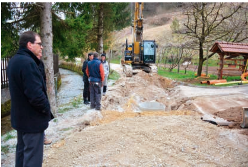
Potek približno 2,6 mio evrov vredne gradnje si je pred kratkim ogledal tudi župan Dušan Strnad.
