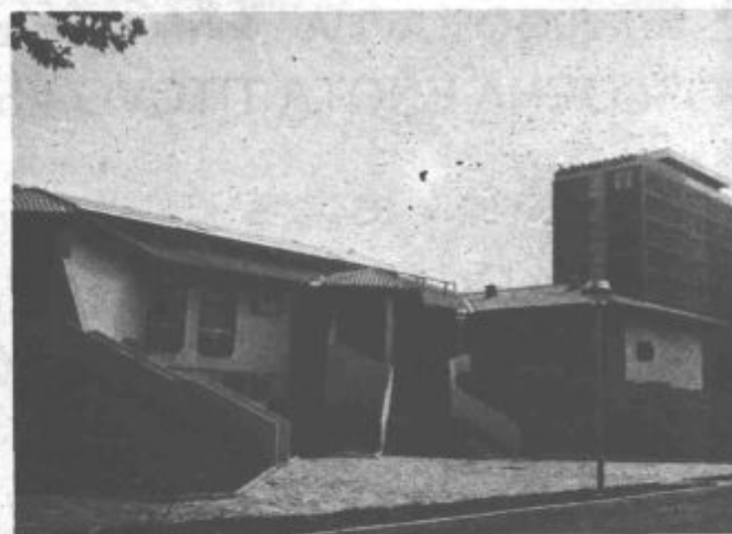
Za Luko Koper smo s prostorskimi elementi DOM 101 zgradili zelo lep gostinski obrat z zaklonišči in ambulanto
