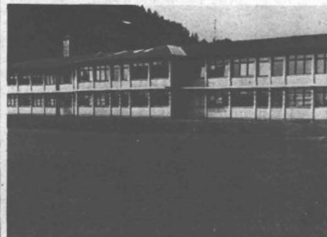
V Trzinu smo zgradili šolo in telovadnico
