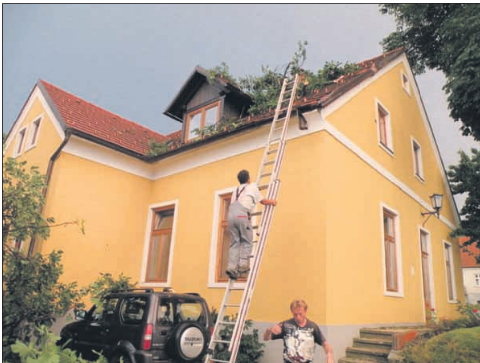
V Bistrici ob Sotli, kjer je odlomljeno drevo poškodovalo streho občinske stavbe (na fotografiji), je delal škodo siloviti veter. Delno je poškodoval več streh, na enem gospodarskem poslopiju jo je skoraj v celoti.
