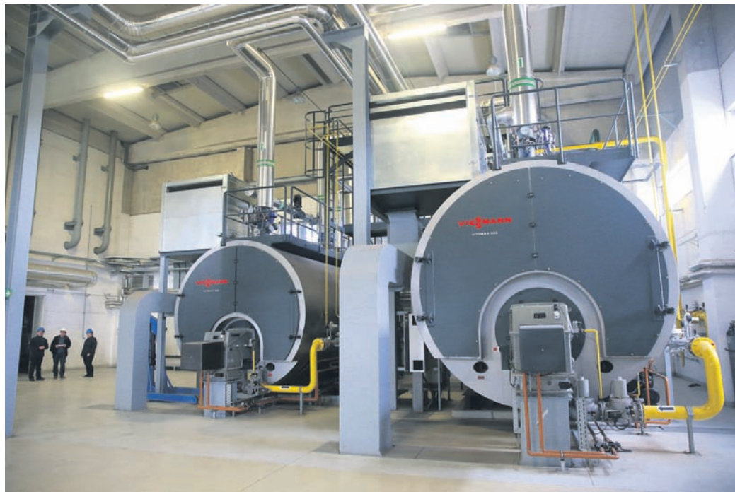
V prostoru s turbinami za kondenzacijo pare in oddajanje toplote za sistem daljinskega ogrevanja Celja
