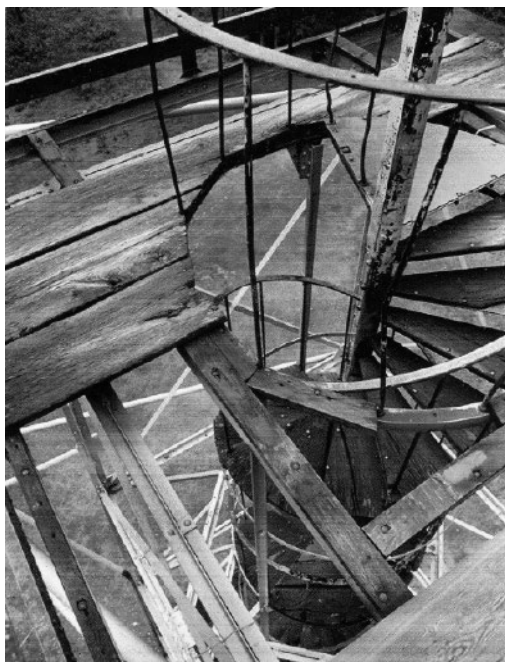
Slika 4: Razpadajoči podest na stolpu. Foto: 84 Igor Napast, 23. 8. 1988.
