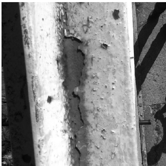
Slika 5: Korozija na jeklenem kotniku. Posnel avtor 7. 9. 2013 na dan odprtja razstave ob 100. obletnici Mariborske koče.
