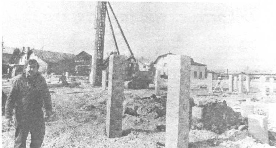
Posnetek prikazuje pilotiranje temeljev za novo osnovno šolo Livada, katere gradnja se bo pričela še v tem mesecu.
