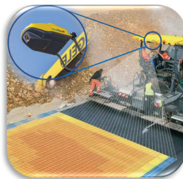
Slika 9. Rezultati meritev temperaturnega polja za finišejem (leva slika) in termoskener na finišeju (desna slika) [Rošer, 2020].
