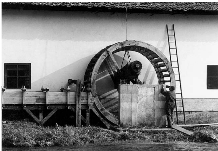
Slika 1. Montaža nove hrastove osi na ležaje skozi vodno kolo furnirnice (foto Vilman, 1994)
