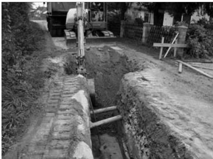
Izgradnja kanalizacije ter obnova vodovodnega sistema
