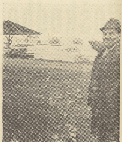
Betonarna je še na tleh, jaz pa bi rad že jutri betoniral
