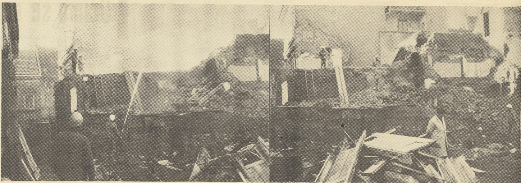
V Mariboru so porušili nekaj starih hiš, da bi napravili prostor novemu hotelu Orel. Zaradi velikega prahu so pri rušenju uporabiti tudi brizgalno
