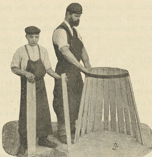
Abb. 21. Das Zusammenstellen der Obstfässer.
