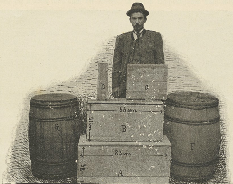
Abb. 18. Die verschiedenen Verpackgefäße. A große, B kleine Kiste, C Postkistchen von oben gesehen, D dasselbe von der Seite gesehen. F großes Faß, G kleines Faß.
