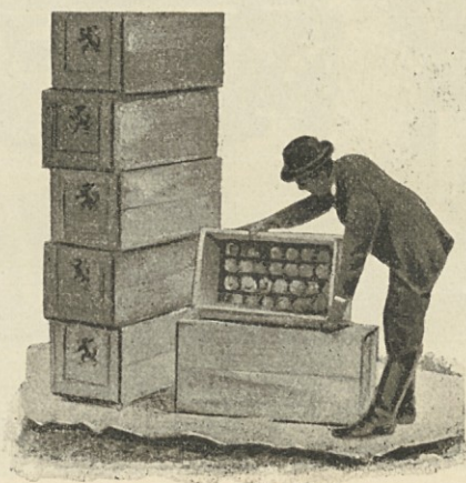
Abb. 30. Umlegen einer mit der ersten Lage beschickten Obstkiste, um zu sehen, ob fest genug gepackt wurde. Die Lage darf hierbei nicht zusammenfallen. Links fünf übereinander gestellte Kisten mit Tafelobst. Die Kisten stehen abwechselnd etwas über, damit zeitlich Luft dazukommen kann.
