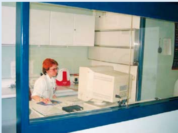
Slika 6: Zaščitno steklo v nadzornem prostoru SPECT-CT (Grmek, 2004)
