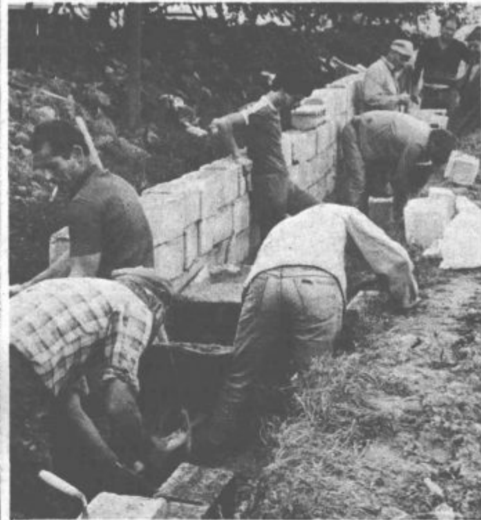
Gradaja primarnega voda na Žarovci, gradbeni del
