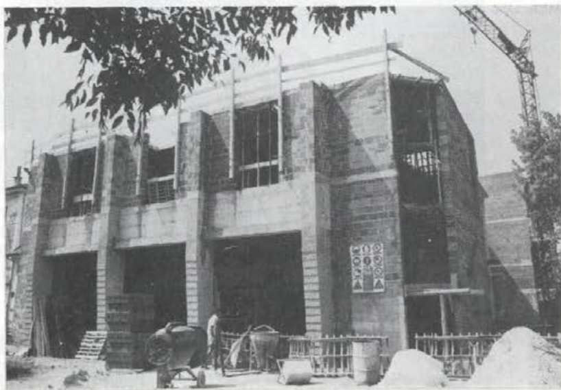
Gradnja novega Katoliškega doma v Gorici
