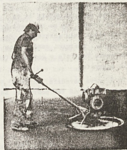
Brušenje betonskega tlaka
