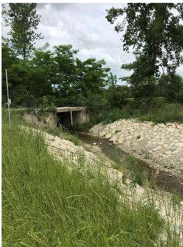
Slika 3. Odvod podzemne vode vodonosnika Krškega polja, projektiran ob izgradnji jazu za hidroelektrarno Brežice (Foto: Urška Pavlič)
