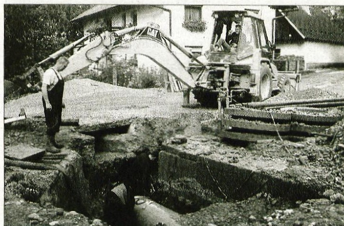
V Zgornjih Dupljah so že obnovili vodovodno omrežje, sedaj pa gradijo kanalizacijo.
