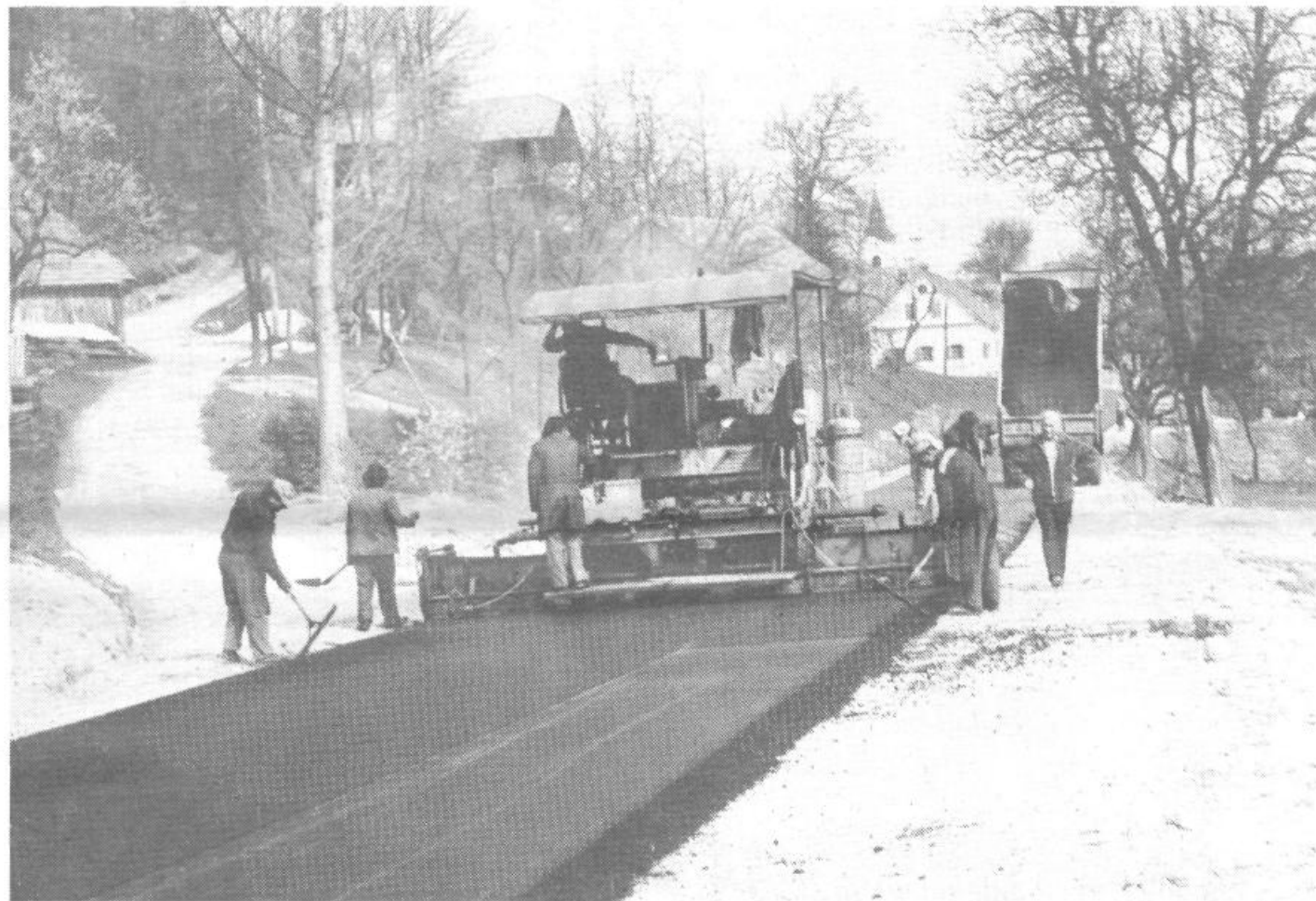
Asfalterji na delu
