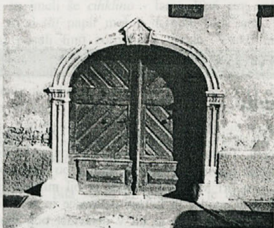
kolona pri Kotlarjevih z masivnima bazama, žlebljenima pokončnikoma in lokom, umetelnima kapiteloma....
