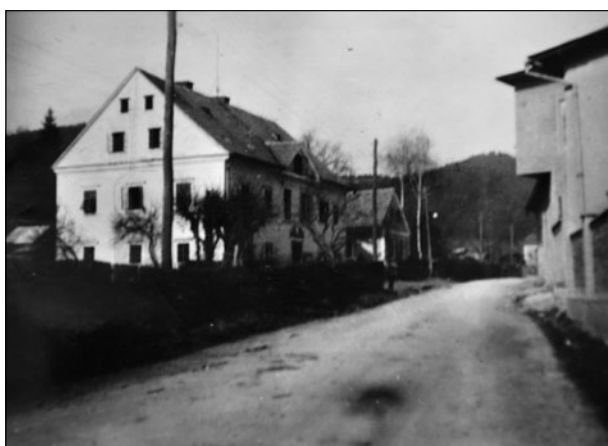
Zreški grad, ki je bil za potrebe Štajerske železindustrijske družbe predelan v stanovanjski objekt, je bil zgrajen leta 1718. Nekaj časa je bil lastnik tega objekta Gustav Wukošek. (Vir: Arhiv župnije sv. Egidija, Kronika župnije Zreče)
