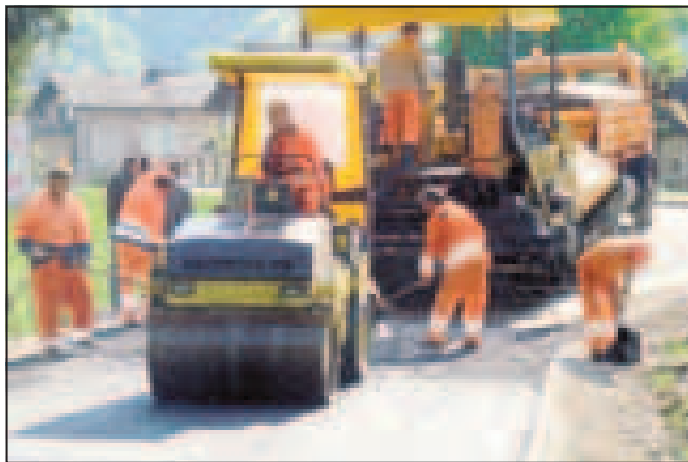
Takole so delavci Cestnega podjetja Ljubljana pridno polagali zadnje metre grobege asfalta.
