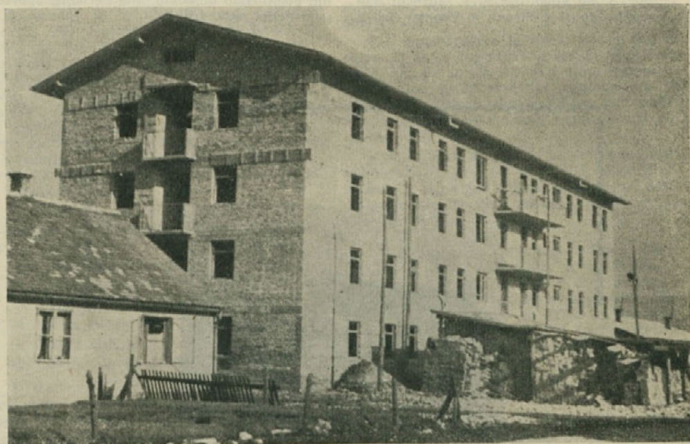
Samski dom v gradnji
