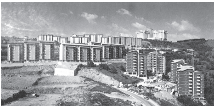
Slika 36: Gradnja nove bolnišnice na Katinari in stanovanjske stolpnice pod njo, ki zakrivajo pogled na pobočje Sv. Marije Magdalene Zgornje.
