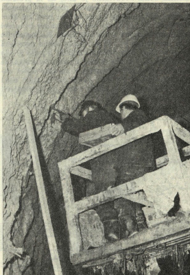
Foto 1. Vgrajevanje merskih klinov za merjenje konvergence
