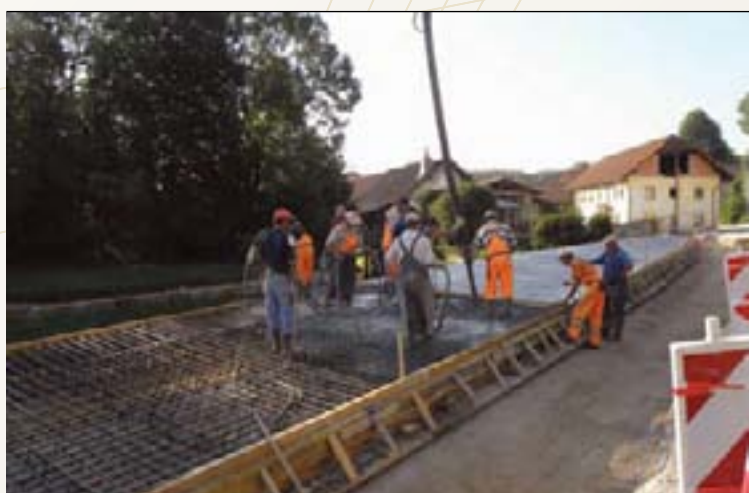
Betoniranje podporne plošče
