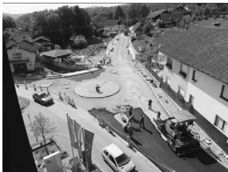
Asfaltiranje krožišča
