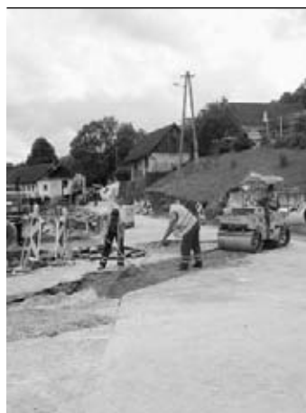
Utrjevanje terena po izgradnji kanalizacije
