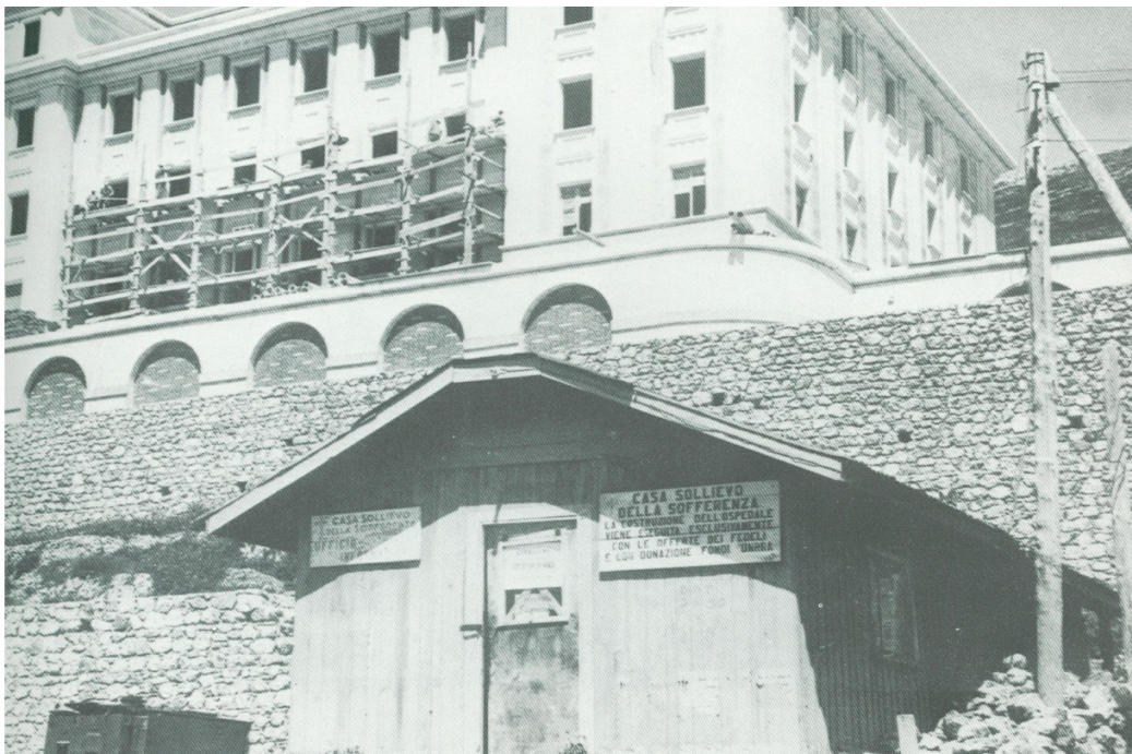
Pogled na dela novi bolnišnici Hiša lajšanja trpljenja v San Giovanniju Rotнду.
