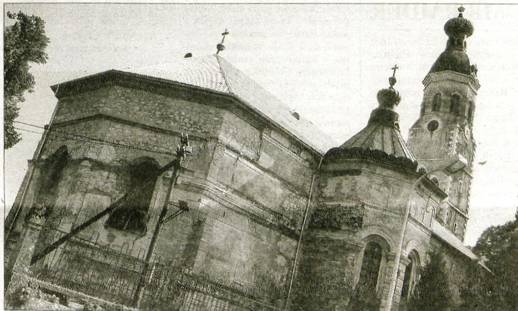
Poškodovana katoliška cerkev v bližini Knina.
