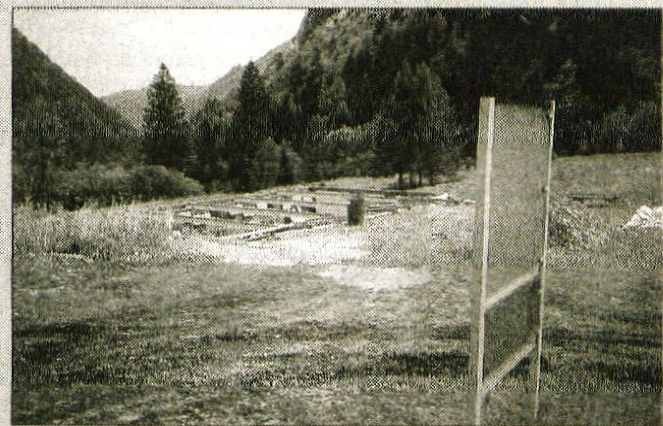
Severni zid spominske kleti so obnovili pred poletjem, za južno stran pa še ni denarja.
