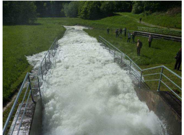
Slika 3: Klivnik – presežena kapaciteta spodnje struge ob odprtju temeljnega izpusta.
