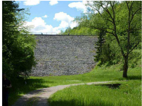
Slika 7: Mola – dolvodno lice pregrade.
