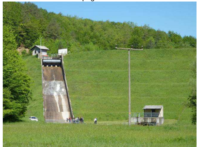
Slika 5: Klivnik – dolvodni pogled na pregrado in visokovodni preliv.
