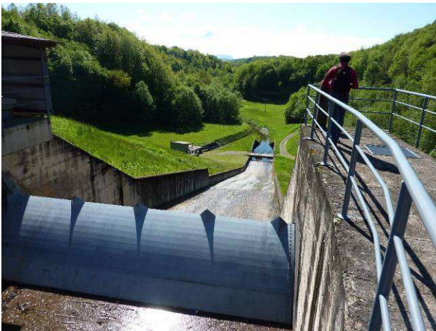
Slika 2: Klivnik – pogled preko visokovodnega preliva, levo je objekt temeljnega izpusta.
