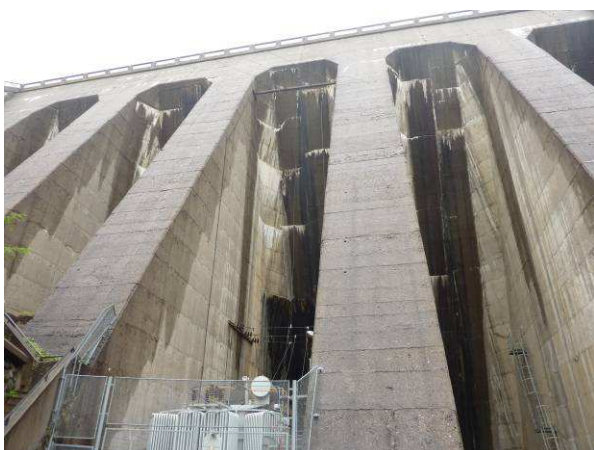
Slika 27: Pregrada je sestavljena iz 15 podpor z glavo v obliki gobe
