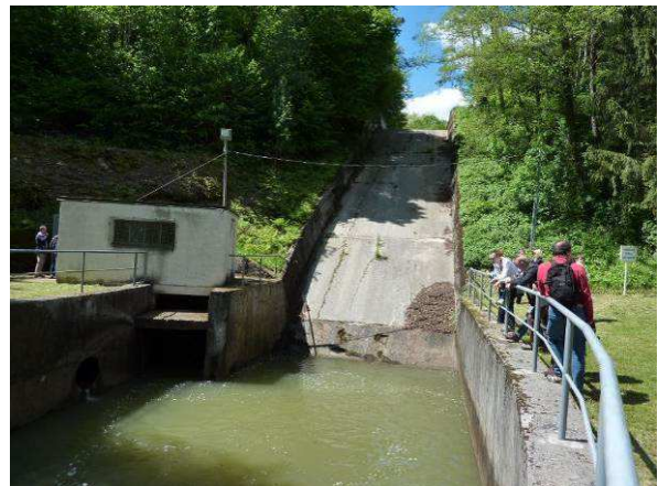
Slika 8: Mola – preliv in temeljni izpust.
