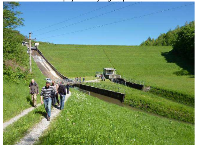
Slika 4: Klivnik – pogled z dolvodne strani.
