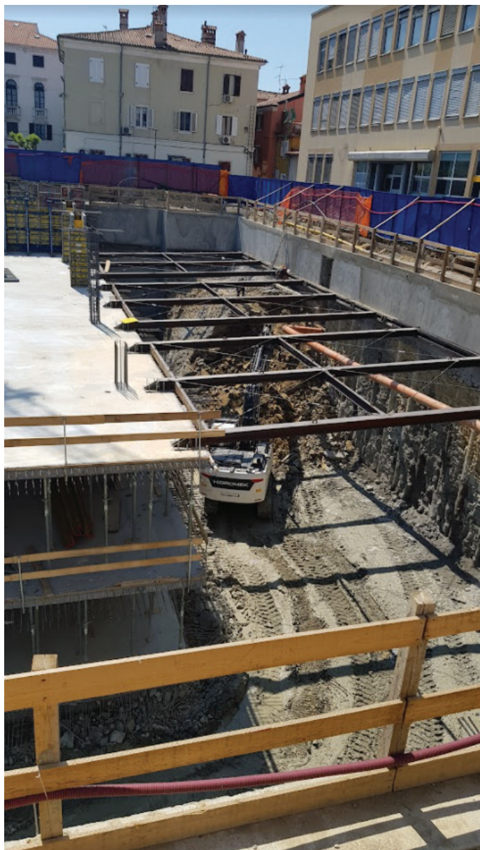
Slika 14. Razpiranje gradbene jame, april 2020.
