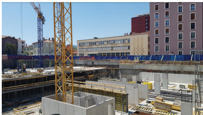
Slika 15. Pogled na gradbeno delovišče, april 2020.
