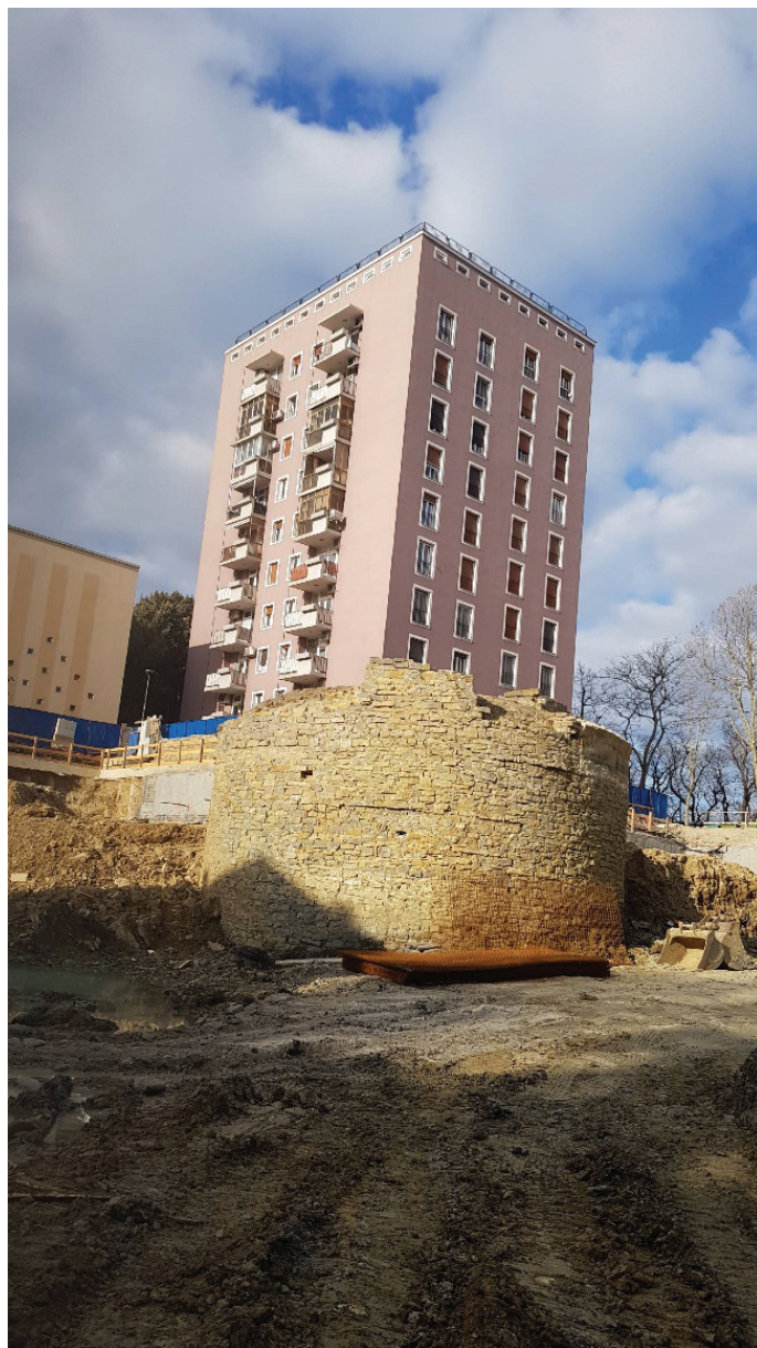
Slika 13. Vodna cisterna, januar 2020.
