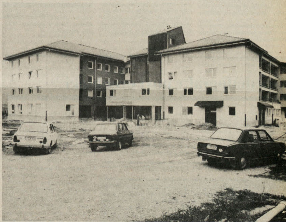
Zaključujejo se tudi dela pri izgradnji doma upokojencev
