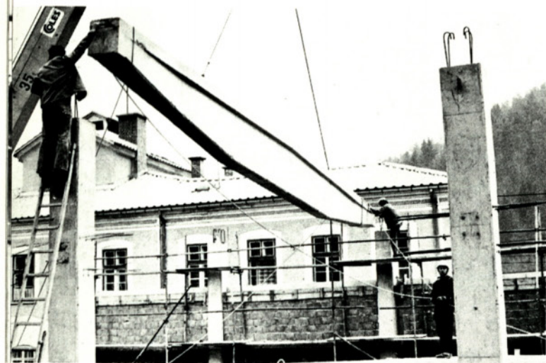
Montaža primarnih nosilcev za predmešalnico vlaken
