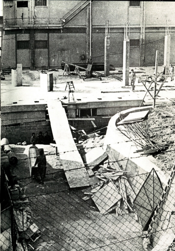
Izdelava temeljev za prizidek k predpredilnici leta 1985
