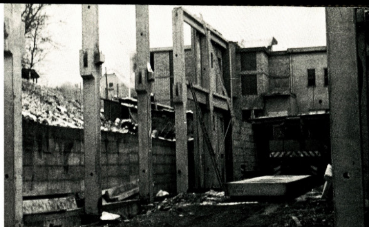
Gradnja prizidka k predilnici sintetike
