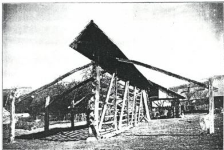
Slika 8. Stegnjeni kozolec z lopo (»klanico«, »podstreškom«). Vas Jezerc pri Ponikvi, občina Trebnje na Dolenjskem.
