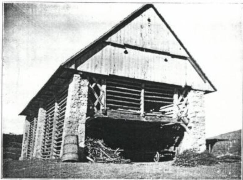
Slika 23. Vezani kozolec (Rovte nad Vrhniko).
