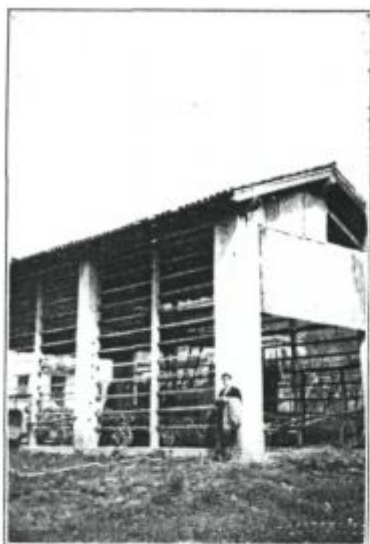
Slika 24 a. Vezani kozolec (Kanal pri Gorici).
