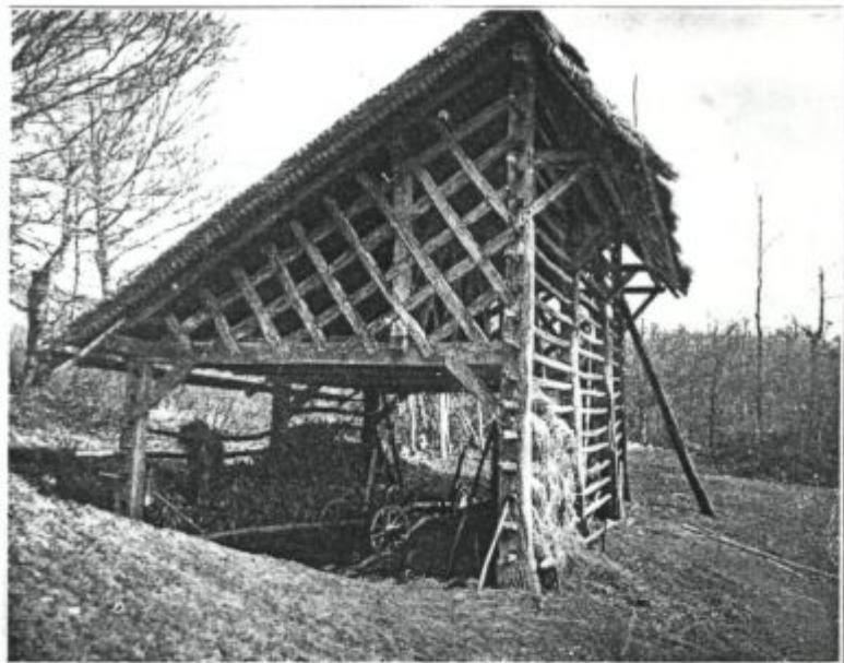
Slika 28. Kozolec na kozla (iz hribov pod Lisco, občina Loka pri Zidanem mostu).
