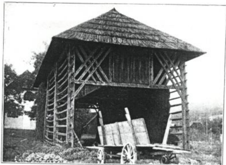
Slika 14. Vezani kozolec (Pliberk, Podjuna).
