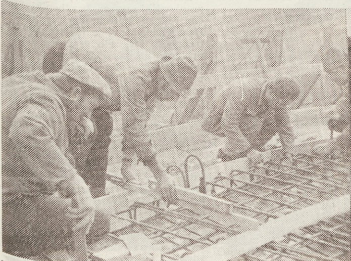
Zadnja kontrola armature
