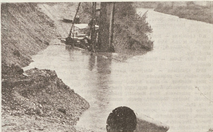
Obilno deževje je napravilo veliko škode. Pri gradnji mostu čez Grubarjev kanal nam je zalilo benoto stroj
