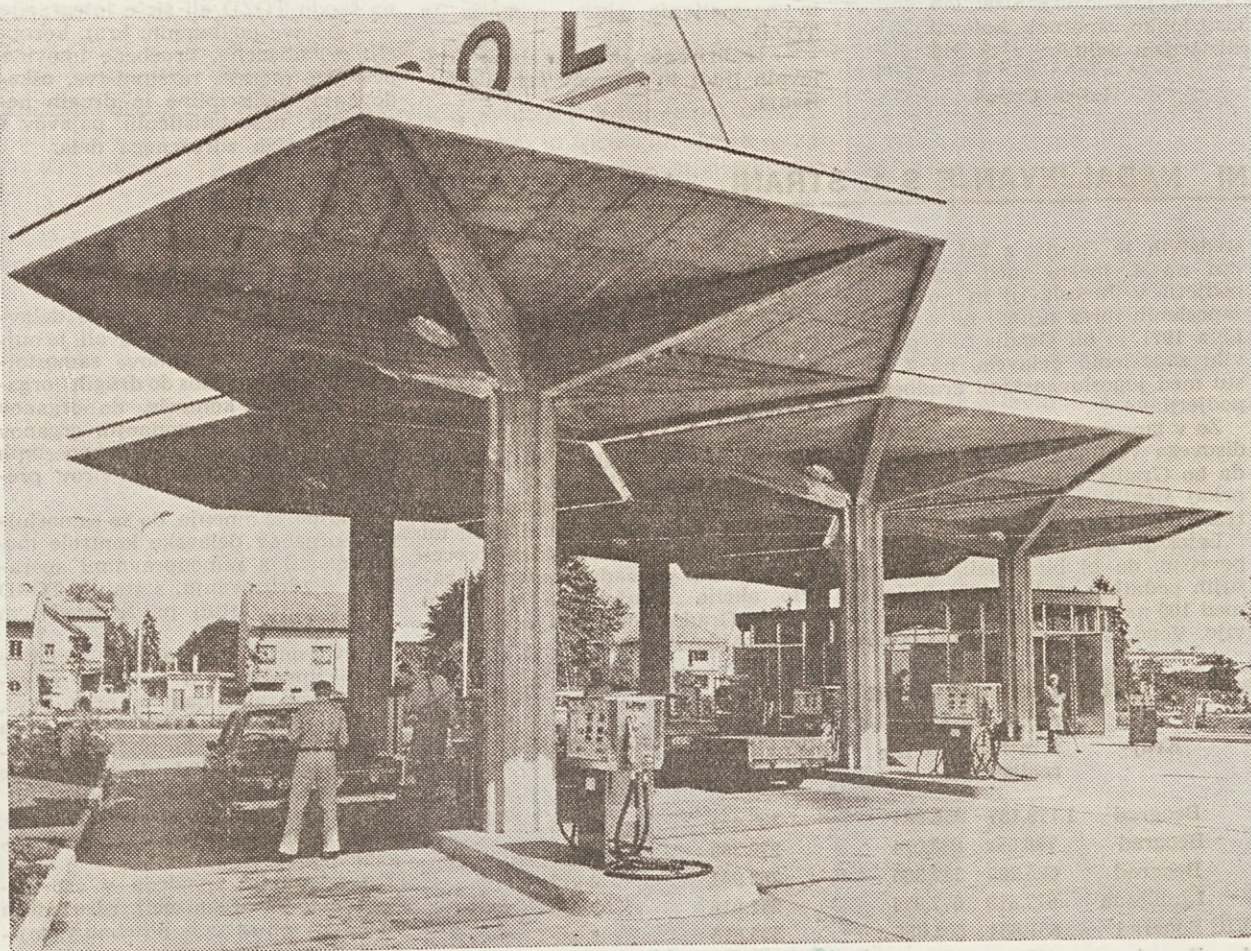
Ena izmed novozgrajenih bencinskih črpalk, ki smo jo za Petrol zgradili v Ljubljani
