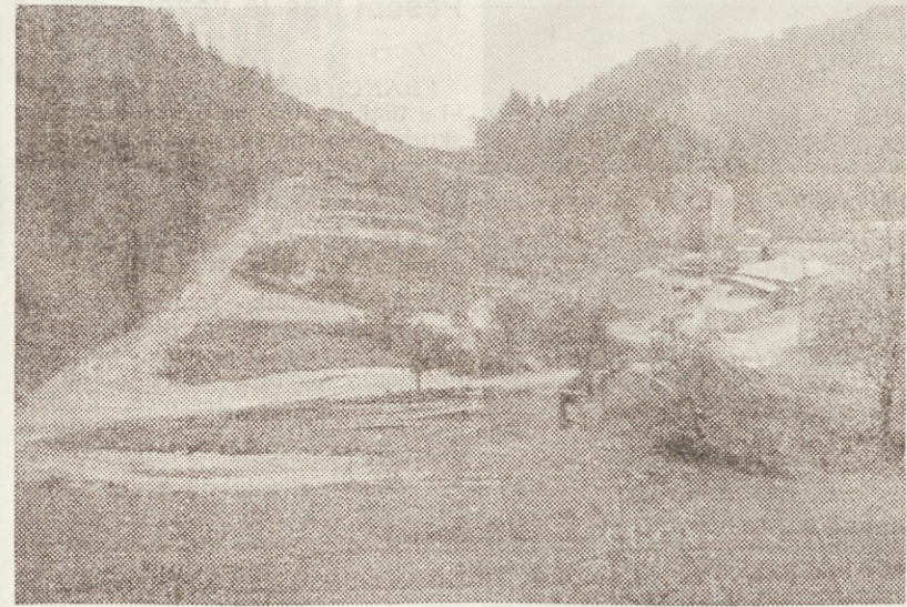
Na gradbišču Slatina. Tudi to dolino bo presegal 440 m dolg viadukt
