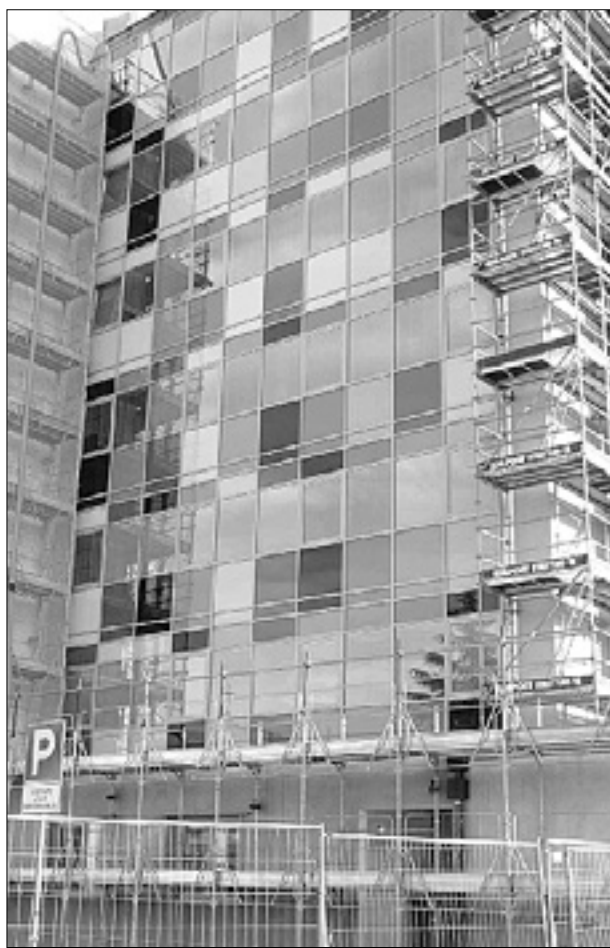
Nova okna na desnem krilu stavbe goriške splošne bolnišnice
