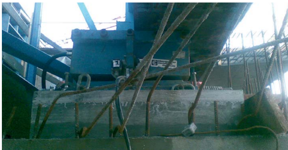
Slika 4 • Postavitev kljuna na narivno hidravliko
