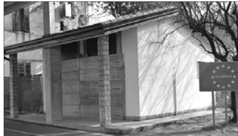
Nekdanja carinarnica je zaščiten z deskami
