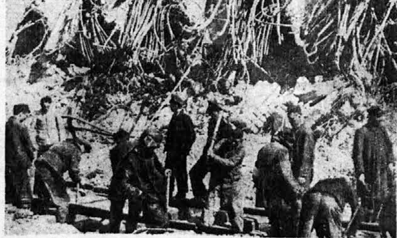
I pionieri del genio ferroviario tedesco rimuovono le macerie e montano i nuovi binari alla stazione di Harkov. — Nemški železniški pionirji čistijo razvaline na harkovski železniški postaji in polagajo nove tračnice.
