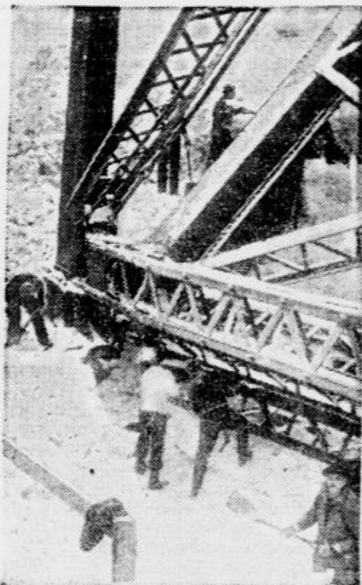
Ameriški delavci odstranjujejo sloviti železni most pod Niagarskimi slapovi. — Konstrukcija je zaradi močnega pritiska zaledenelih slapov zgrmela v globlino
