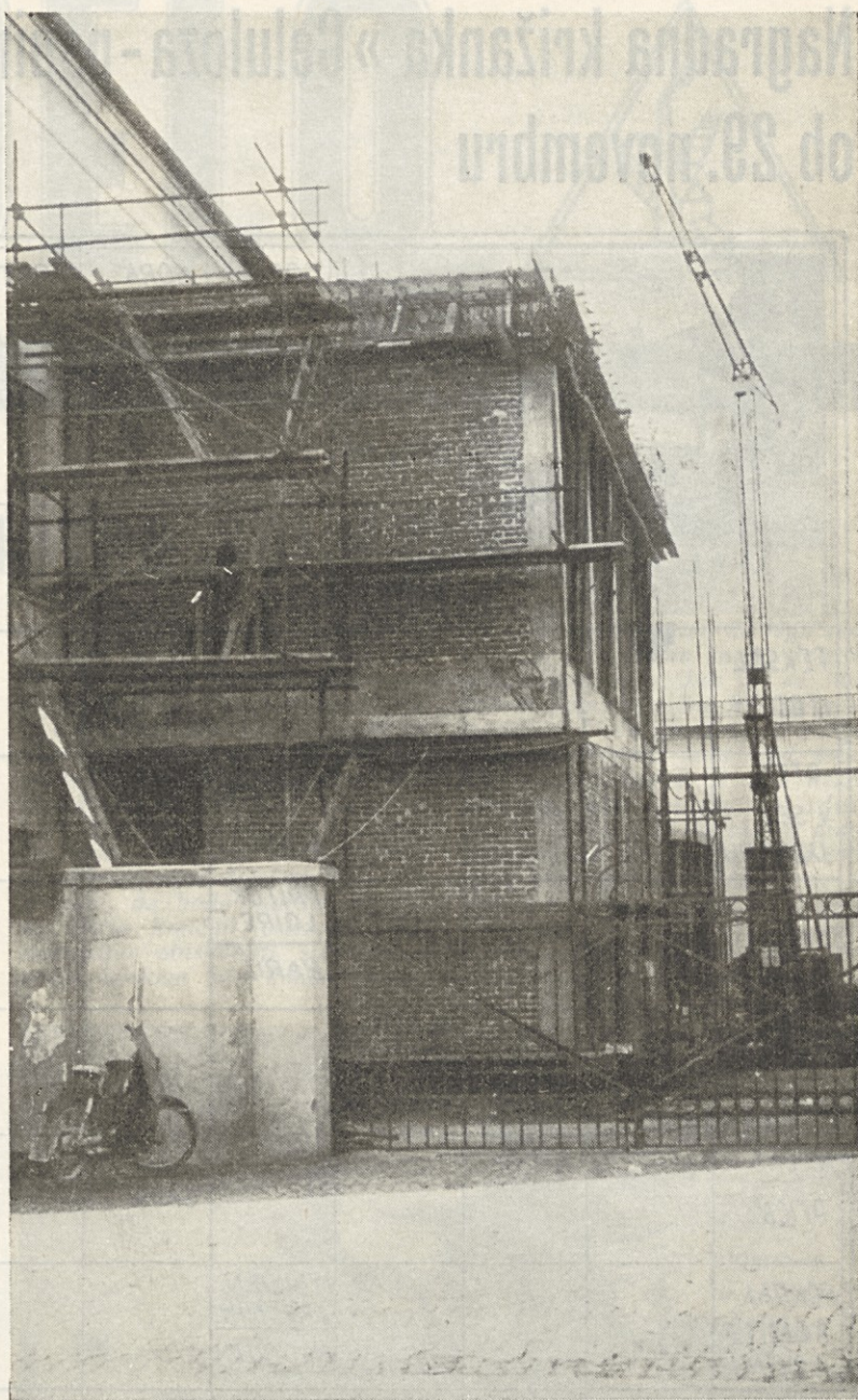
Ob stavbi II. PS bo kmalu zgrajen del objekta za mokro razpuščanje papirnih odpadkov
