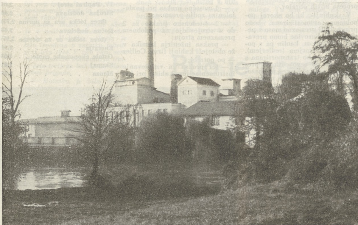
Pogled z levega brega Ljubljanice proti tovarni. V ospredju kotlarna
