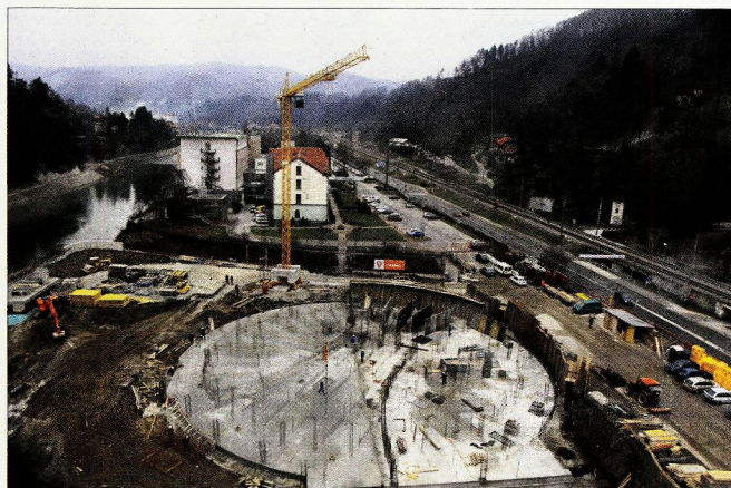
Gradbišče termalnega centra, ki bo zgrajeno do septembra.
