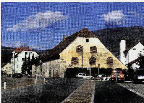
Zavod za varstvo kulturne dediščine opozarja na dragocnost gospodarskega poslopja v Novi Cerklji, občina pa se že več let trudi, da bi se objekt lahko v celoti porušil, na njegovem mestu pa bi zraseda trgovina.
