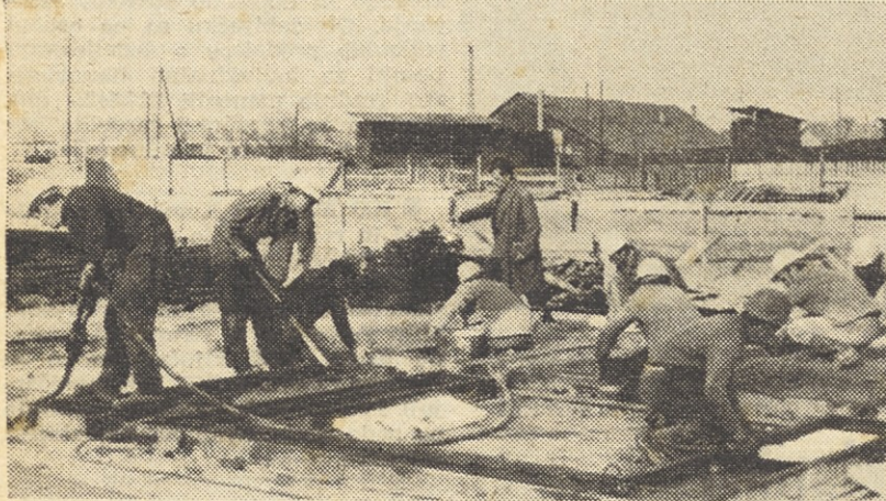
Vajenci iz Maribora pri betoniranju betonskih elementov
