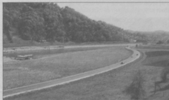
Regionalna cesta G1-5 ob jezovni zgradbi HE Boštanj (foto: R. Kaše)
