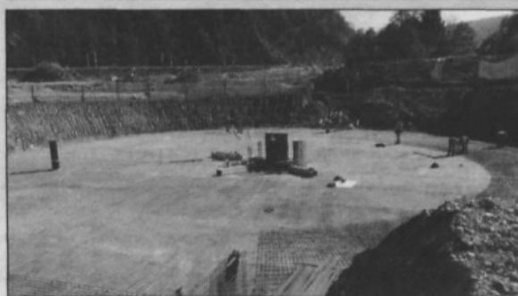
Izgradnja biološke stopnje na Logu - areacijski bazen (foto: arhiv Občine)
