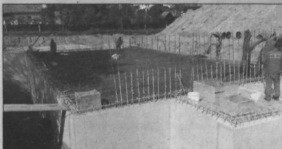
Izgradnja razbremenilnika L2 pri Srednji šoli Sevnica (foto: arhiv Občine)
