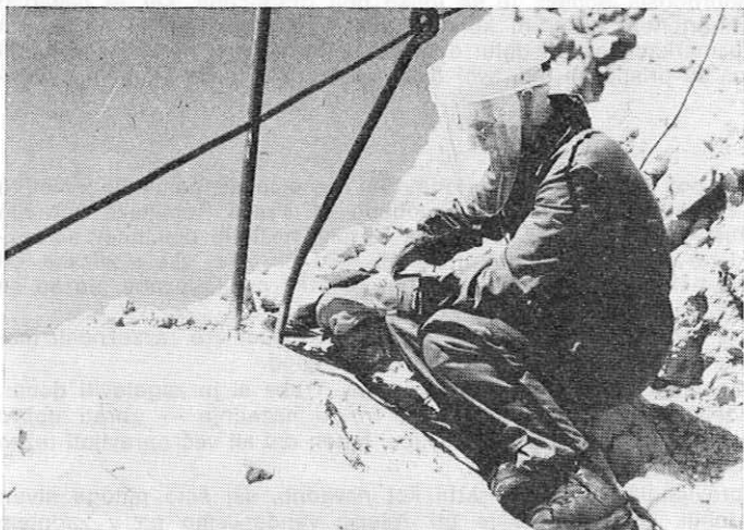
Miha bo s kotno brusilko odrezal odsluženi vrvi klin
